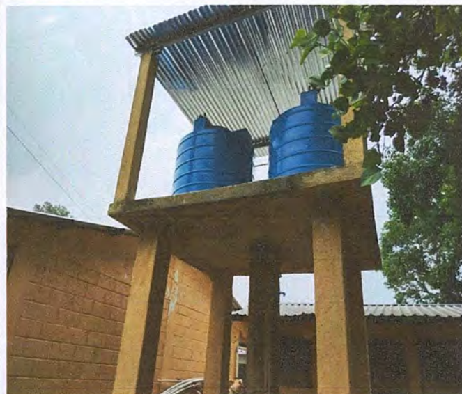
Foto 2: Se refuerza la terraza que sostiene a los depósitos de agua y se instalan para obtener suficiente agua potable para mejorar los servicios sanitarios.
