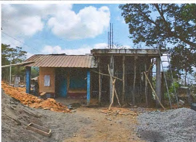
Foto 3: Mejoramiento en las instalaciones de la cocina, colocando una terraza para ubicar depósitos de agua exclusivamente para el área de la cocina.
